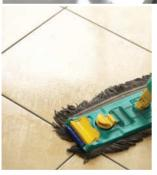
Die Reinigung, nach dem Verlegen" dient zur Entfernung der Spachtel-, Zement-, Kalk-, und Einpressmörtelrückstände. Sie ist nach Abschluss der Bauarbeiten, sowohl für die glasierten als auch unglasierten Fliesen obligatorisch. Die Reinigung darf nicht durchgeführt werden, wenn die gefliesten Oberflächen sehr warm sind (z.B. im Sommer bei Sonnenbestrahlung), da die Wirkung der aggressiven Chemikalien sehr viel stärker wird. Im Sommer in den kühleren Stunden des Tages ausführen.
